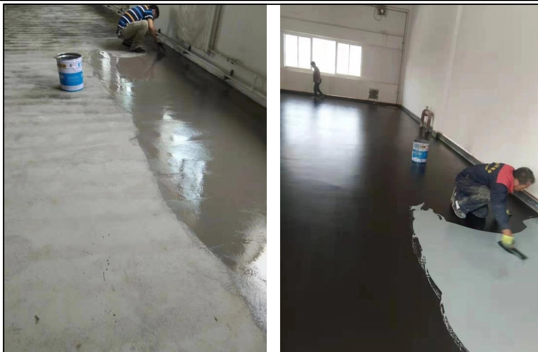
图 3.4-7 防静电环氧自流平地坪施工现场图
